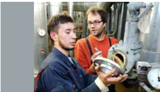
DB Services Mitarbeiter bei der Wartung einer raumlufttechnischen Anlage
